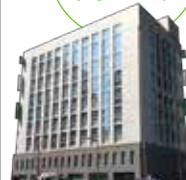
▲東京支店外観
